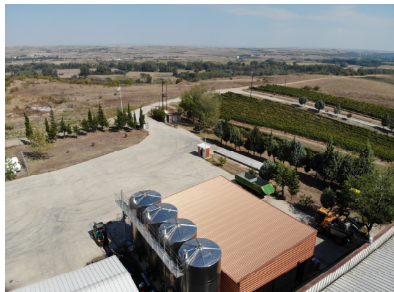
Εικόνα 16. Εβρίτικα Κελλάρια – Εξωτερική άποψη
