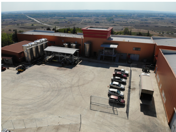
Εικόνα 15. Εβρίτικα Κελλάρια – Εξωτερική άποψη
