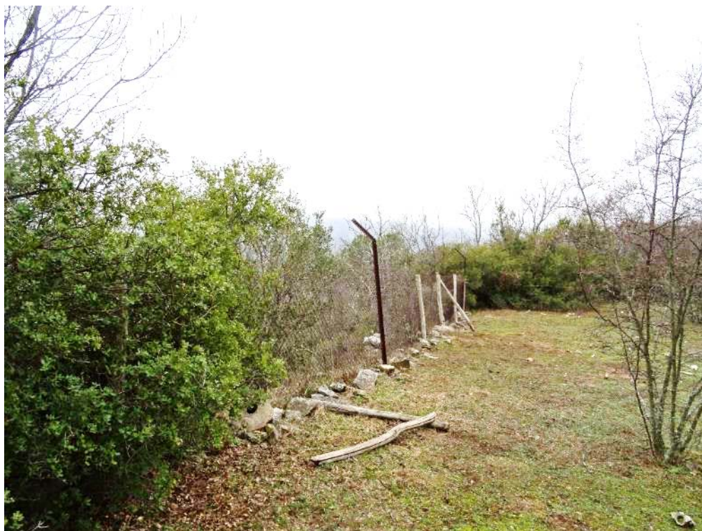
Εικόνα 6: Ανομοιόμορφο ύψος πασσάλων περίφραξης Λιβερών
