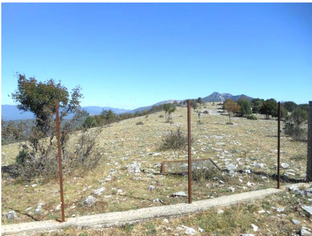
Εικόνα 8: Σιδεροπάσσαλοι δίχως περίφραξη δίπλα στη πόρτα του ΧΤΑΠ Αγ. Κοσμά
