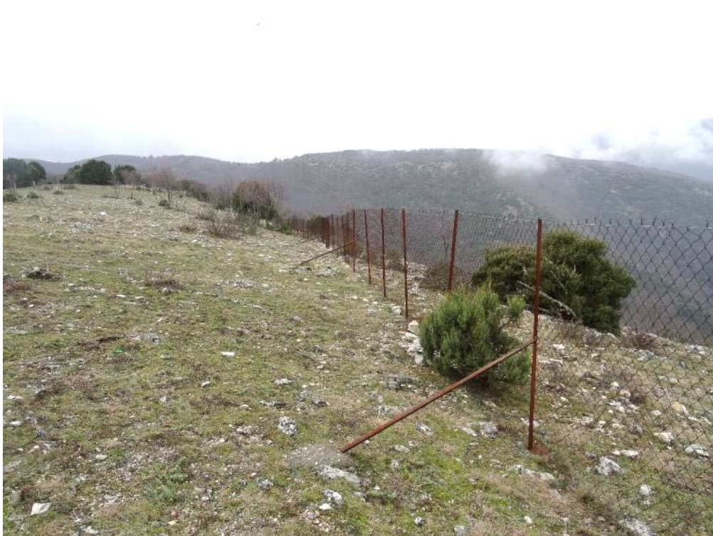
Εικόνα 9: Αντιρρήδες ανά 5 πασσάλους στο ΧΤΑΠ Αγ. Κοσμά
