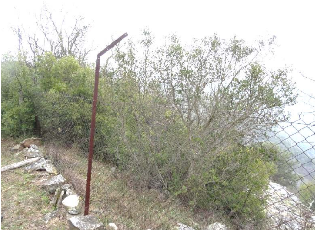
Εικόνα 3: Ενδεικτικός σιδηροπάσσαλος για τη νέα περίφραξη
