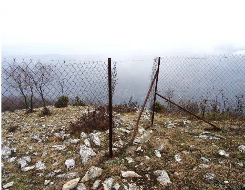
Εικόνα 7: Τμήμα χωρίς περίφραξη του ΧΤΑΠ Αγ. Κοσμά
