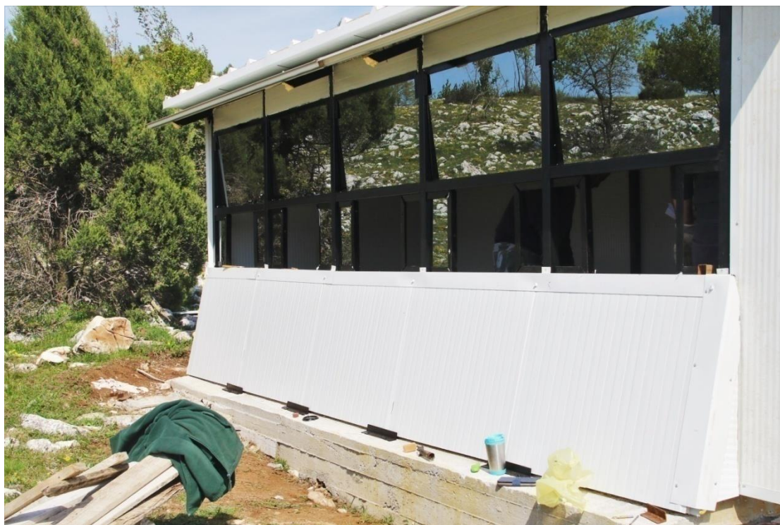
Εικόνα II.2.4: Υπό κατασκευή φωτογραφική καλύπτρα του ΧΤΑΠ. Φωτ: Π. Βαφείδης
