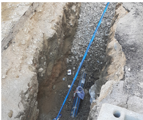
Подмяна на тръбопроводи
