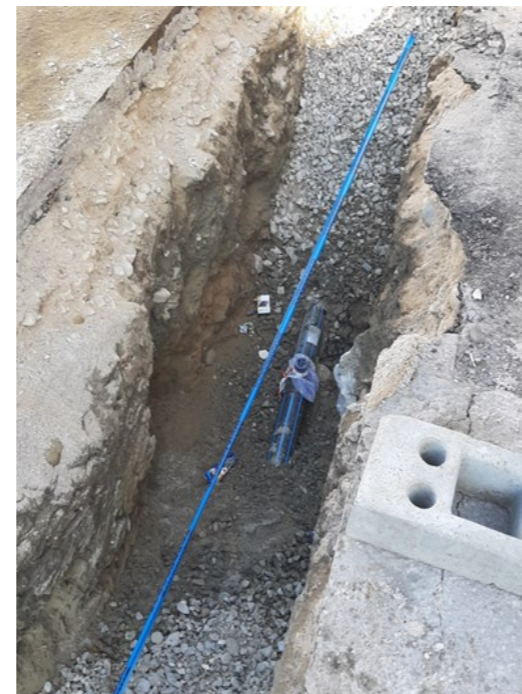
Αντικατάσταση των αγωγών νερού
