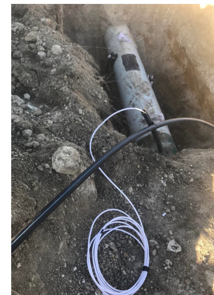
Монтаж на ултразвуков разходомер
