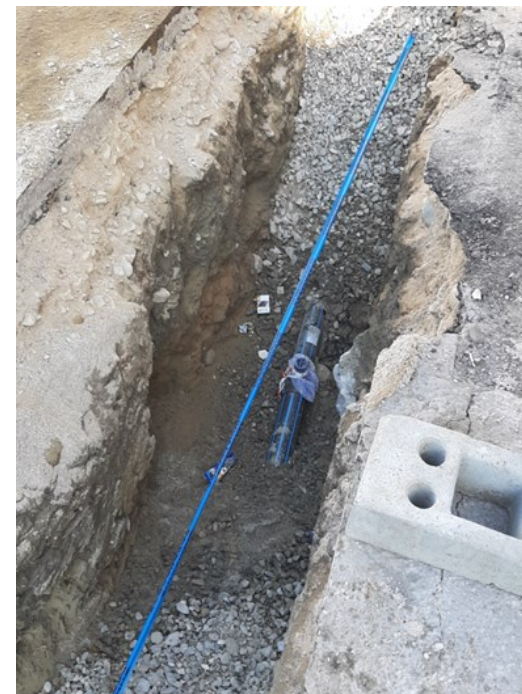
Реконструкция на тръбопроводи
