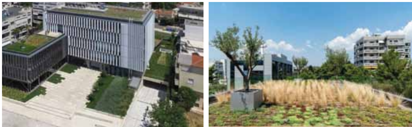
Καλές πρακτικές: πράσινες στέγες – νέο κτίριο γραφείων της Noval SA στο Χαλάνδρι
