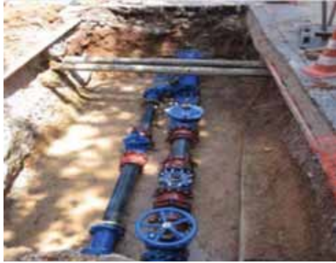
Βαλβίδες Μείωσης Πίεσης (PRVs)
