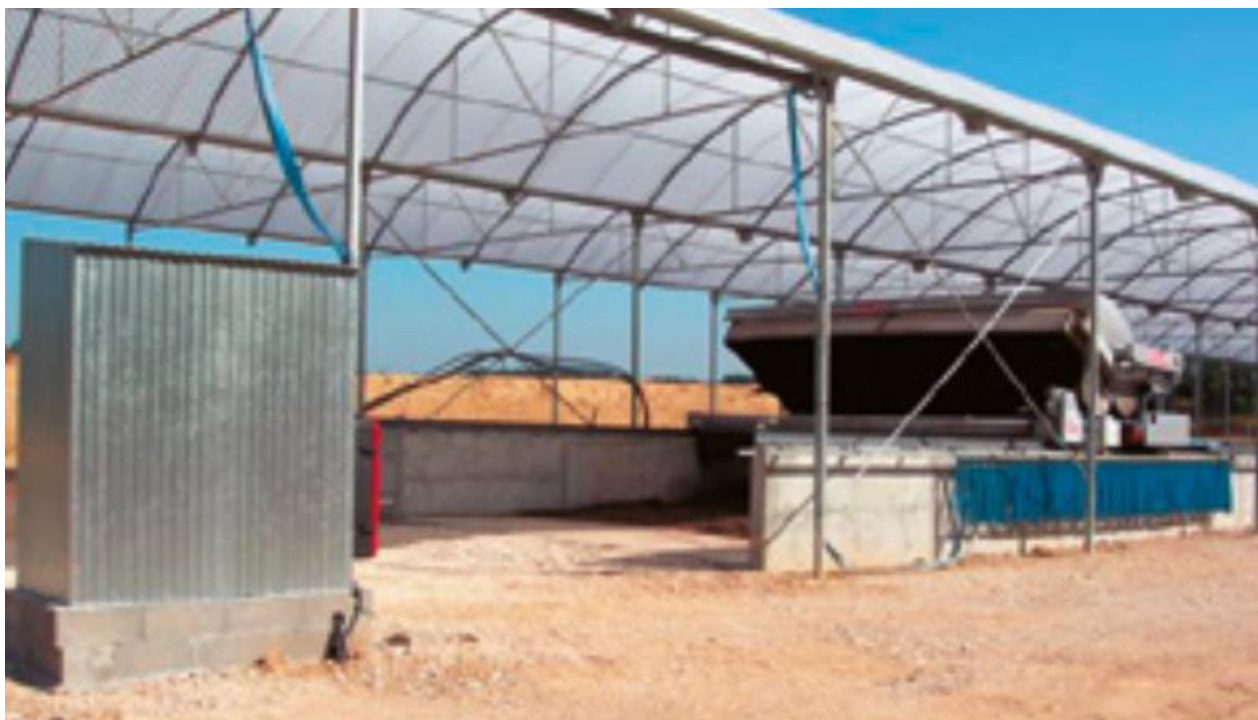
Фиг. 2. Компостиране в открити клетки с навес
