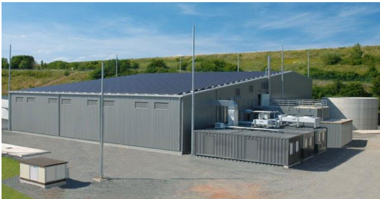
Фиг. 11. Инсталация за суха метанизация
