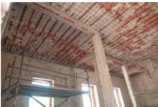
Реставрационни работи в прогрес (юли 2019 г.)
