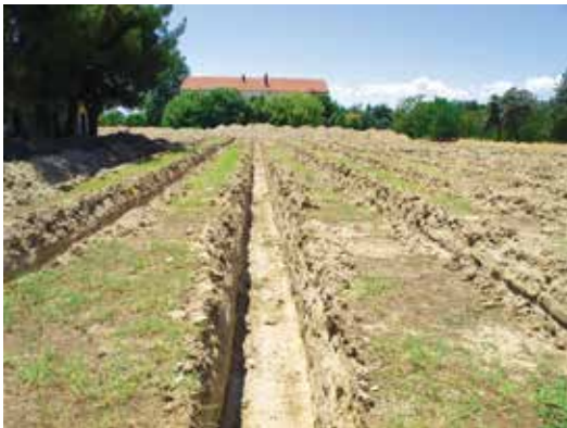
Εκσκαφές για την εγκατάσταση Γεωθερμικής Ενέργειας (Ιούλιος 2019)
