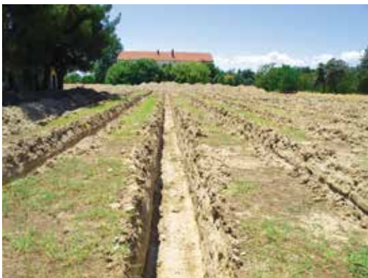
Разкопки за геотермична инсталация (юли 2019 г.)
