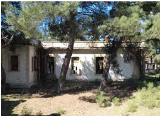
Сградата на музея Ксенакис преди реставрацията
