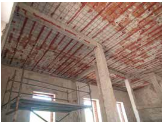
Διαδικασία αναστήλωσης (Ιούλιος 2019)
