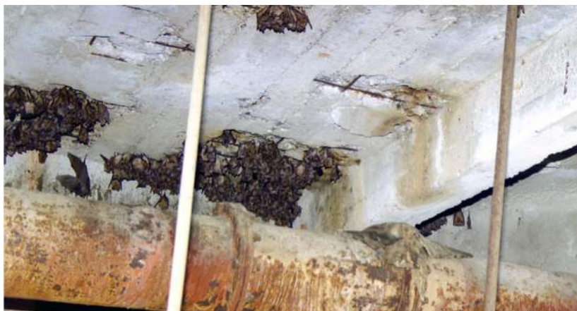
Колония на Голям подкованос ( Rhinolophus ferrumequinum ), обитаваща вентилационна шахта на рудник
