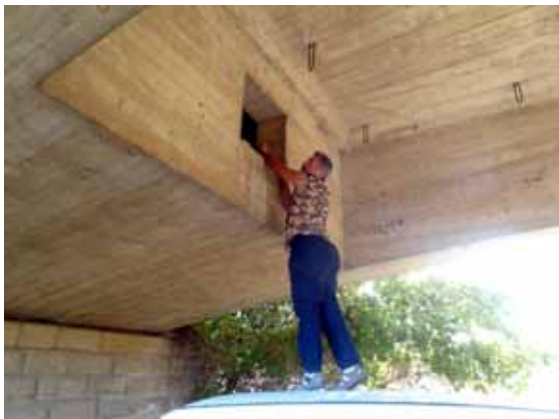
Έλεγχος για παρουσία νυχτερίδων σετσιμεντένια γέφυρα © R. Mecheva
