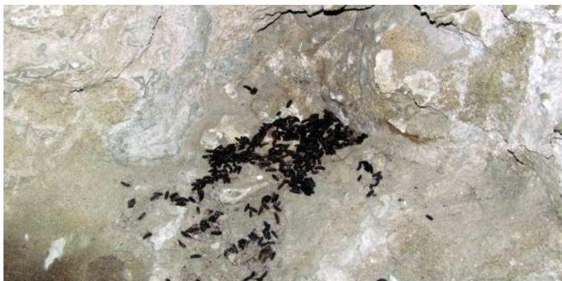
Често при оглед на постройки се намират следи от присъствие на прилепи – гуано
